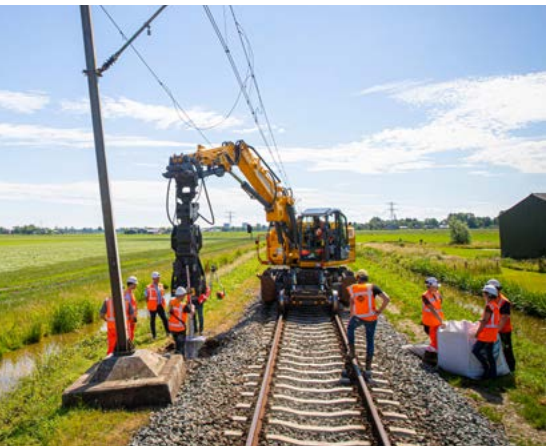
Erneuerte Fundamente, Heerhugowaard-Enkhuizen, Niederlande
