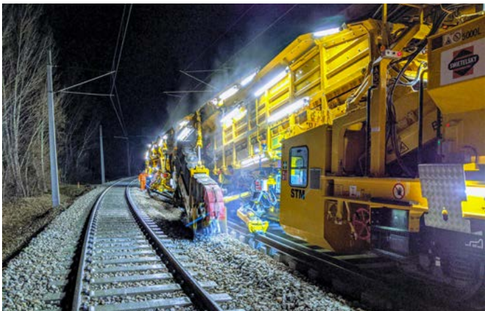
Maschinelle Gleisneulage auf der WLB-Strecke, Traiskirchen-Baden, Österreich
